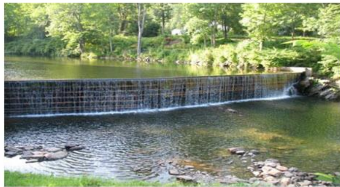
Fig. 31.11. Timber Dam.
